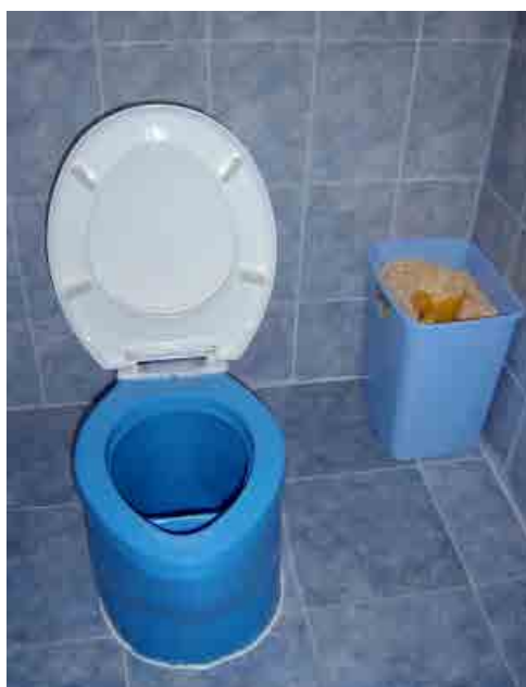
Interieri i tualetit Ecosan , (UDDT), i ndërtuar në shtëpi në Bullgari. Fotografia: Earth Forever
